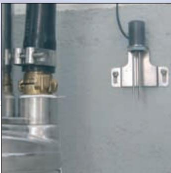
Nachgerüstete Steuerung, an Schachtwand montiert, zum steuern einer Schmutzwasserpumpe ohne Schwimmerschalter.
